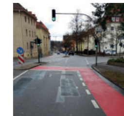
Aufgrund der vormals aufgemalten Abbiegepeile hielt der Autoverkehr regelmäßig bei Rot auf dem Radfahrstreifen. Nach einem Hinweis des ADFC Regensburg an die Straßenverkehrsbehörde wurden die Markierungen entfernt – ein wichtiger Schritt für mehr Sicherheit und freie Fahrt für den Radverkehr.
